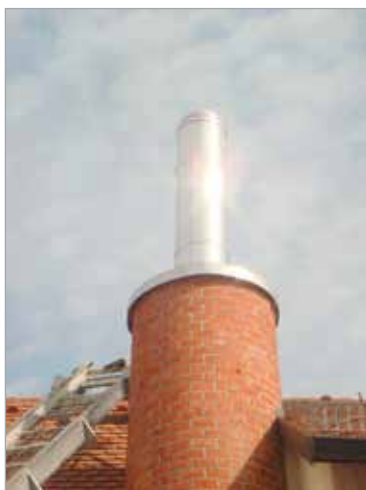
Kaminkopfverlängerung inkl. Abdeckung mit Überstand aus VA
