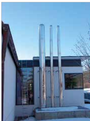
Abgasanlage für Öl-Heizung, Toilettenabluft und gewerbliche Küche
