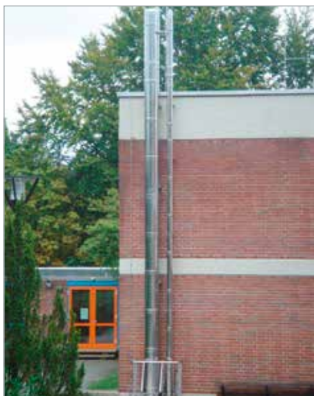
Außenwandkamin für 4er Kaskaden-Gas-Brennwertheizung und Blockheizkraftwerk
