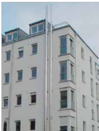
Abgasanlage für Brennwertkessel
