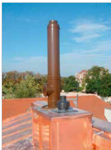
Kamingruppe: Kaminkopfverlängerung in farbiger (pulverbeschichteter) Ausführung und Abgasleitung aus PP
