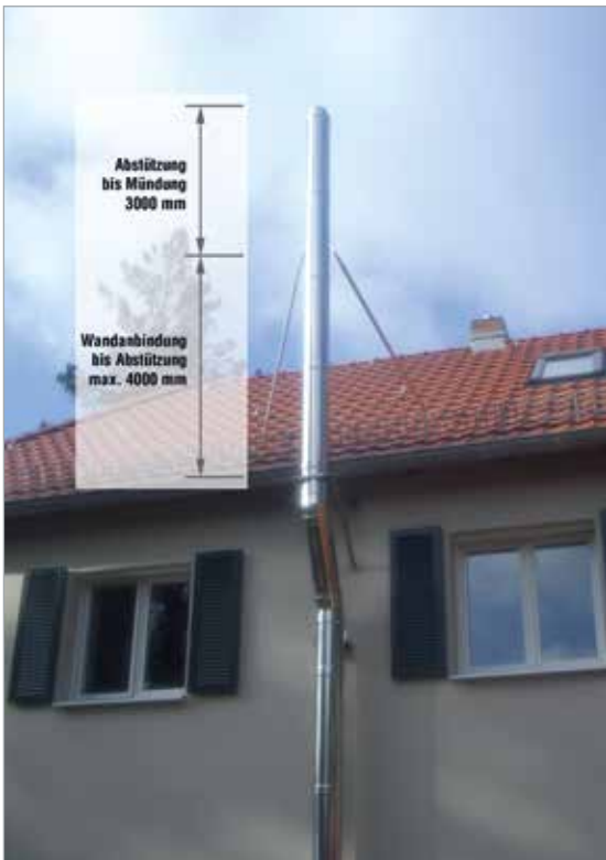
Geprüfte Montagemöglichkeit TÜV SÜD Bericht Nr. A 2042-0013
