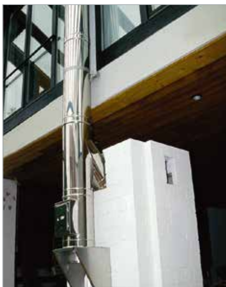
Abgasanlage innerhalb eines Gebäudes
