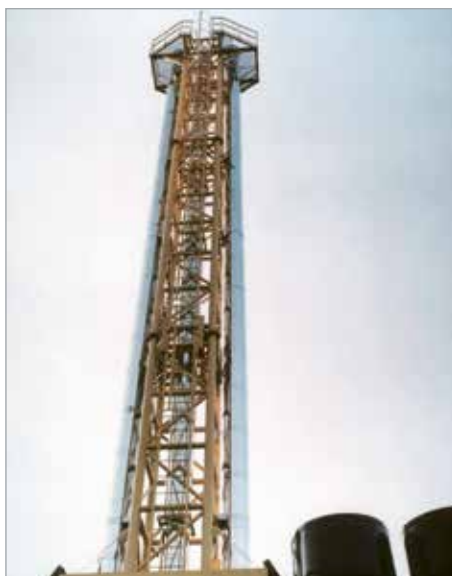
Freistehende 3-zügige Abgasanlage
