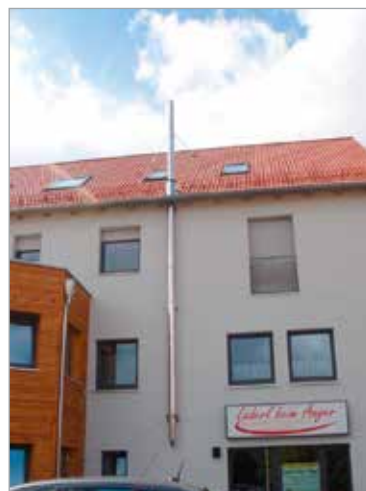
Abgasleitung an der Fassade
