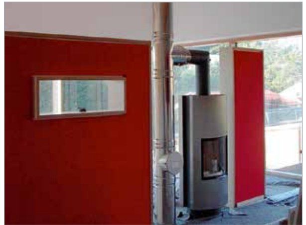
Abgasanlage innerhalb eines Gebäudes
