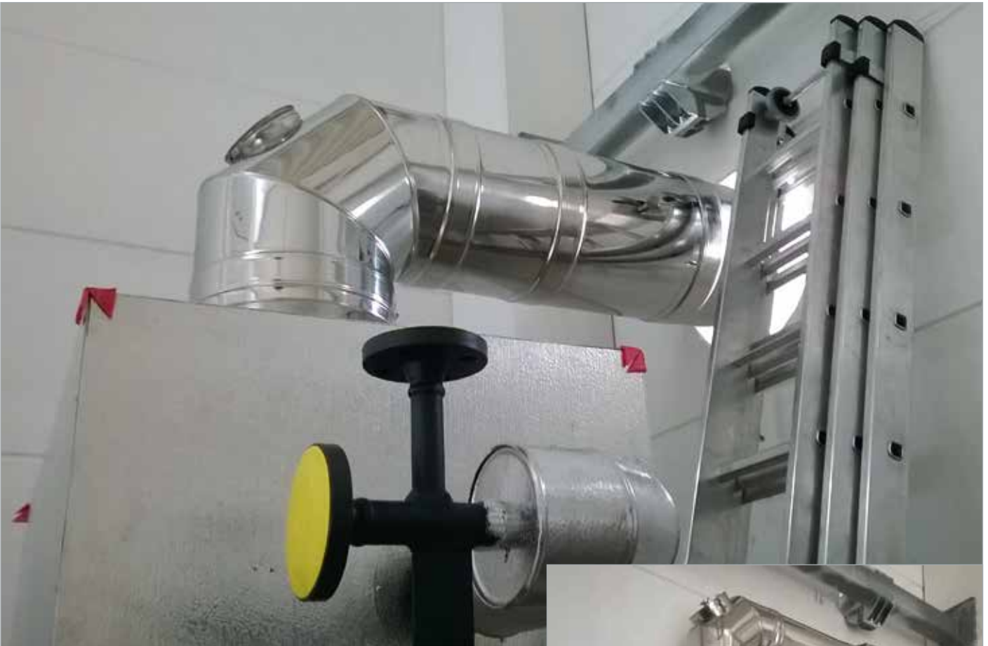
STAR DUO mit geflanschem Kesselanschluss
